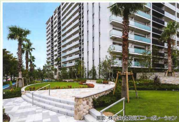
▲第9回建築部門受賞「リビオシティ・ルネ葛西」(共同住宅/東葛西九丁目) 撮影:株式会社長谷工コーポレーション
